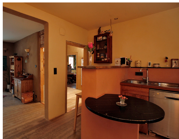
02 Eine thermisch aktivierte Küchentheke aus massivem Lehm zur solaren Bauteiltemperierung, in Bereichen, wo die passive Solareinstrahlung nicht hinkommt
