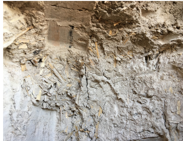
06a und b Uruk, Eanna-Zikkurat Westecke vor den Erhaltungsarbeiten (a) und gelbes Stroh im Lehmörtel des bestehenden Lehmsteingefüges (b)
