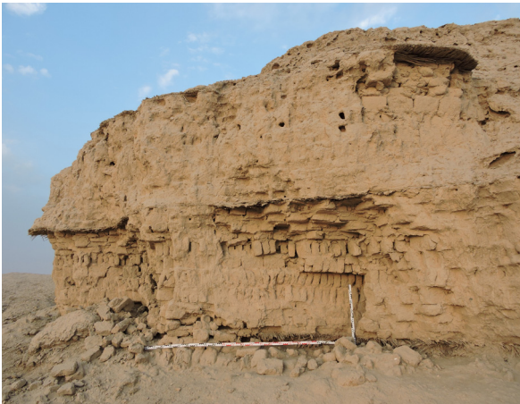
06a und b Uruk, Eanna-Zikkurat Westecke vor den Erhaltungsarbeiten (a) und gelbes Stroh im Lehmörtel des bestehenden Lehmsteingefüges (b)
