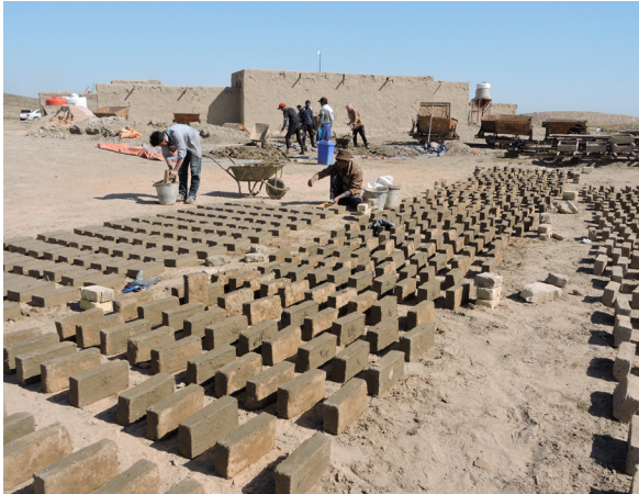
07a und b Herstellung von Lehmsteinen nach der traditionellen Methode (a) und ein Blick auf die Westecke der Eanna Zikkurat nach Abschluss der Restaurierungsarbeiten (b) im Jahr 2019
