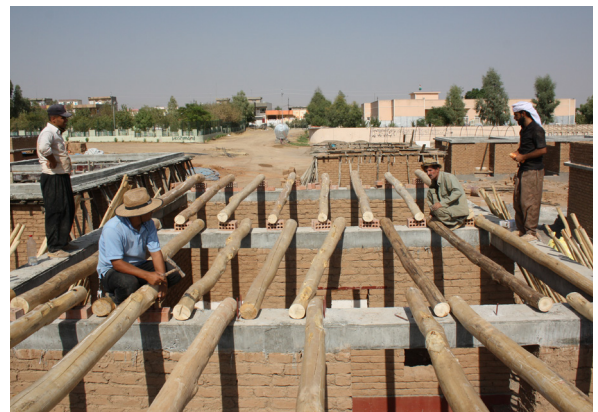
11 Baustelle: Das Dach
