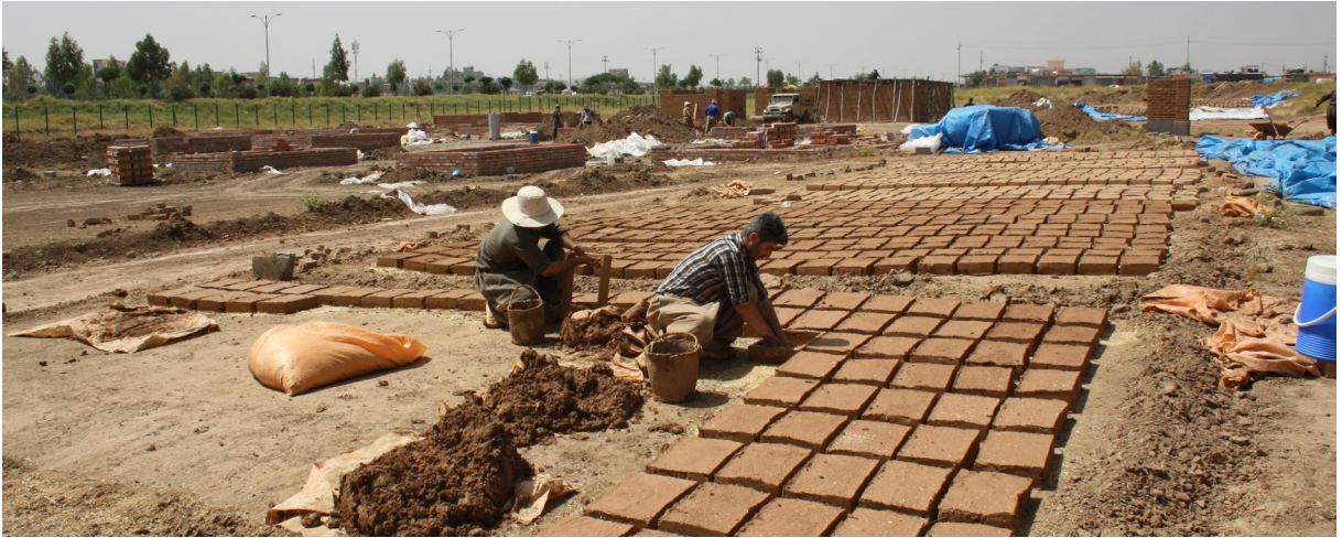
09 Baustelle: Herstellung von Lehmsteinen
