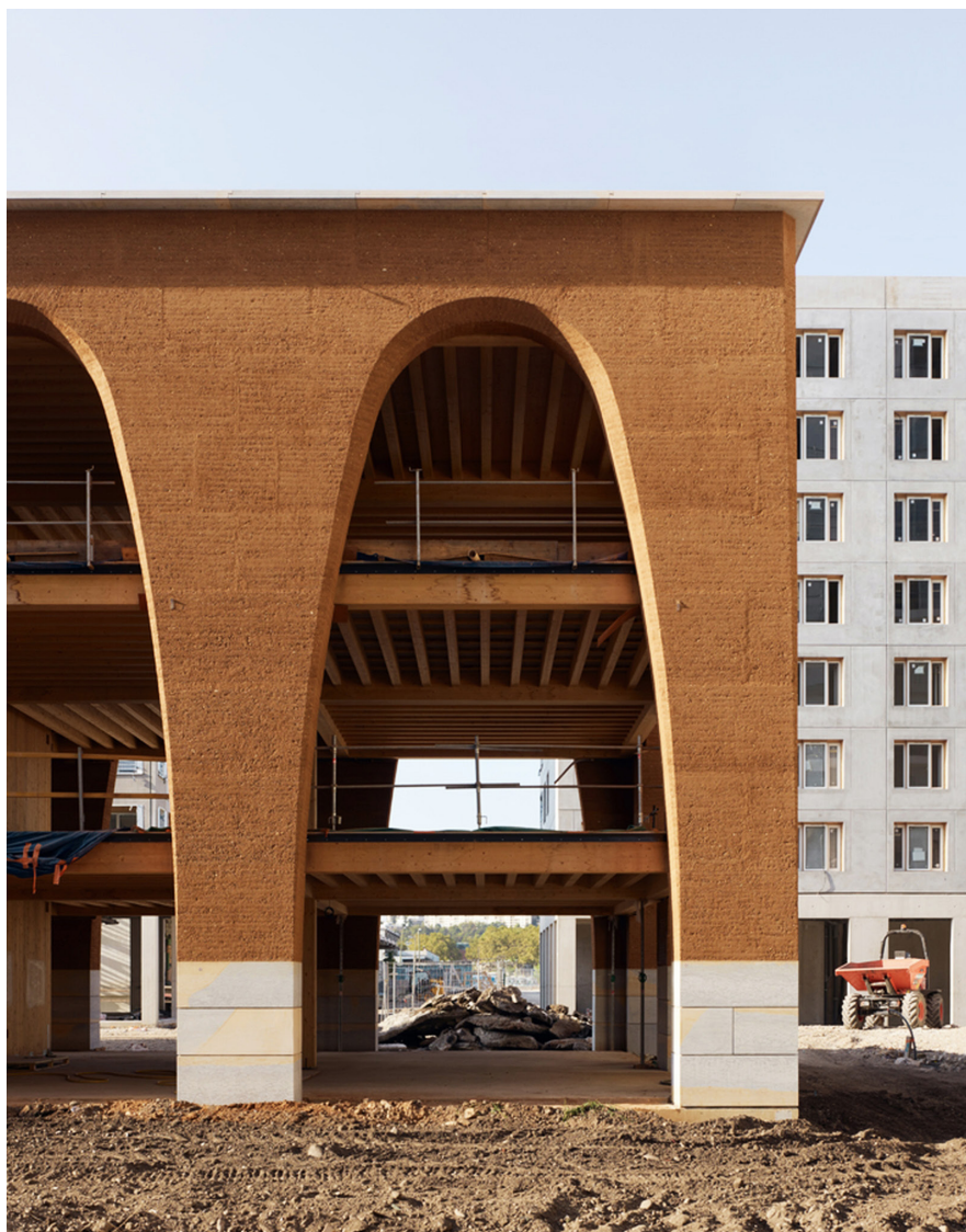
12 Fertiggestellter Rundbogen (© F. Fouillet)
