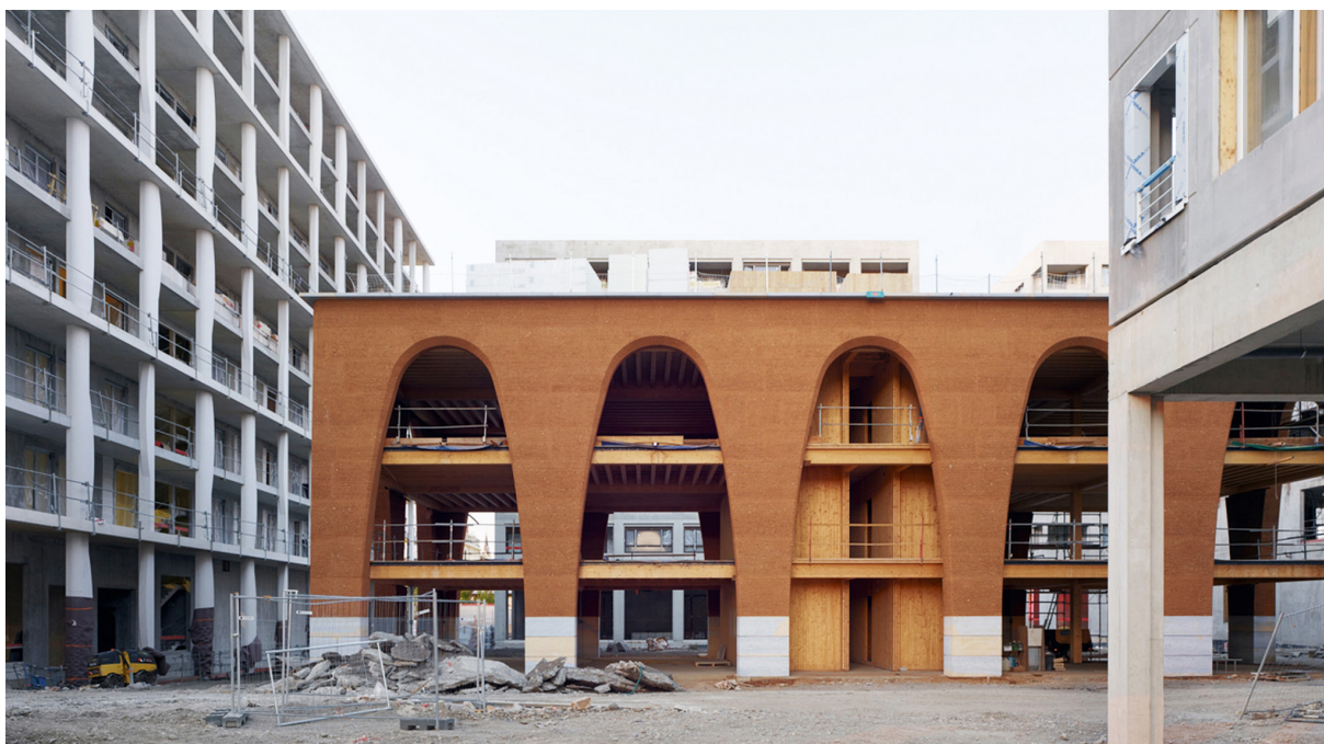
01 Rohbau der L'Orangerie im Kontext (© F. Fouillet)
