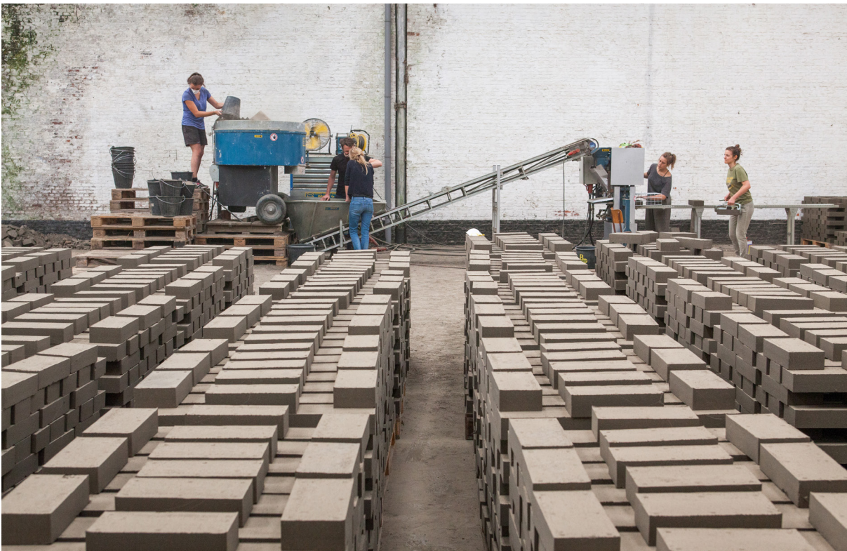
08 Edegem 2 : Lehmsteinproduktion für das erste öffentliche Lehmgebäude in Belgien: 19.000 Steine wurden in 3 Wochen aus lokalem Lehm von Boom, 2 km entfernt von der Baustelle, hergestellt. (Foto: Thomas Noceto)
