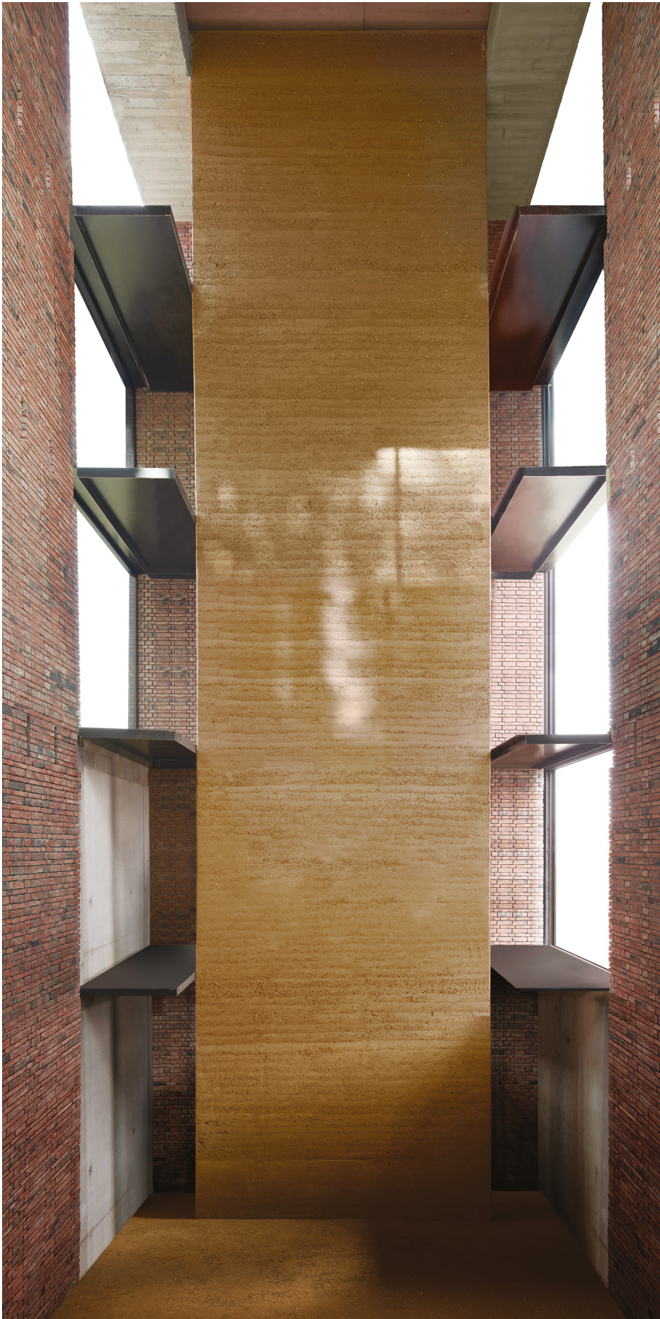
12 WALL: Eine 15 Meter hohe Stampflehmwand von BC materials und Het Leemniscaat für AST77 architects. Die Stampflehmischung wurde aus Aushub vor Ort hergestellt unter Zusatz von Sand und Kies. (Foto: Steven Massart)
